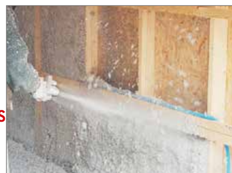
FLOCAGE DE OUATE DE CELLULOSE SUR MUR (NÉCESSITE POMPE HAUTE PRESSION ET LANCE DE FLOCAGE EN OPTION)
