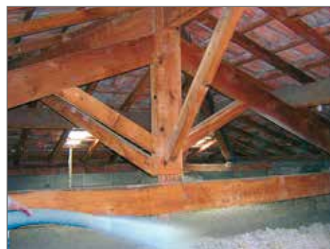
REMPLISSAGE DE COMBLE AVEC DE LA OUATE DE CELLULOSE
